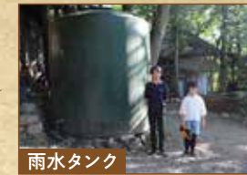
雨水タンク 温室で使う水を1万リットル貯められる。一般的には1日1人200リットル使う
